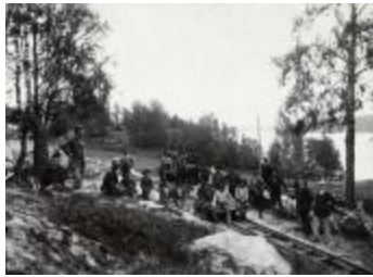
Järnvägsbygge vid Drevviken (LX2006-0301)
