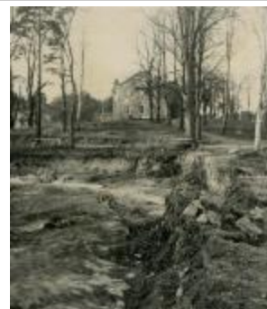
Nora Herrgård, schaktningsarbeten för Danderydsgården (se_ab_dhbf_00153_Master)
