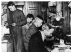
Engbergs mekaniska verkstad (se_ab_sahf_LX2000-0185)
