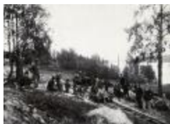
Järnvägsbygge vid Drevviken (LX2006-0301)
