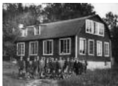
John Berglunds Mekaniska Verkstad (se_ab_sahf_LX2000-0131)
