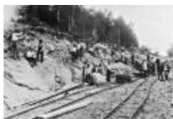
Bygge av Nynäsbanan (se_ab_hhg_09472)
