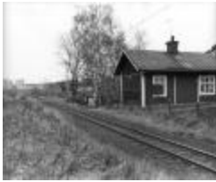
Banvaktstugan vid Enstalund 1980 (se_ab_tahf_4224)
