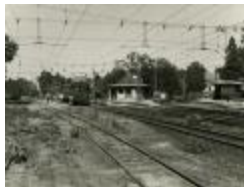
Djursholms Ösby station (se_ab_dhbf_01027)
